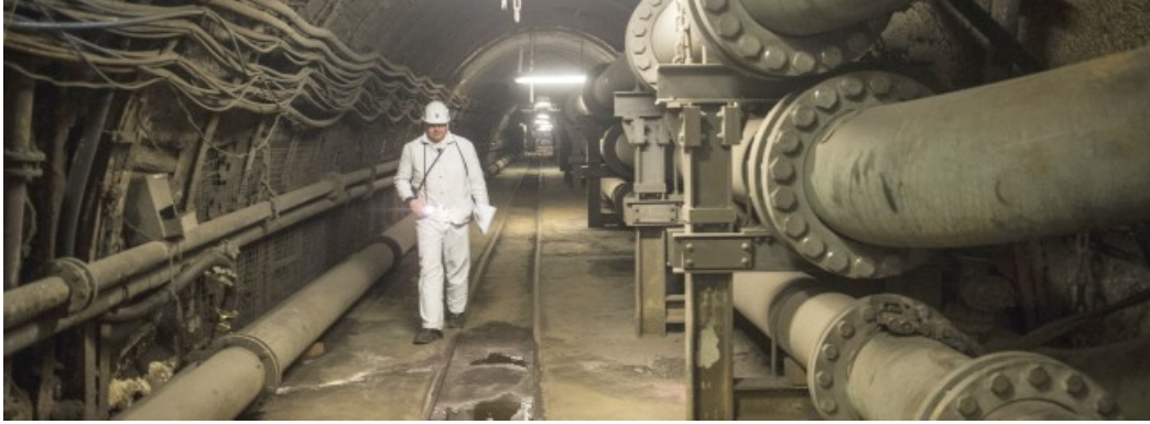
Auf der ehemaligen Essener Zeche Zollverein läuft das Grubenwasser zusammen. Foto: Sebastian Konopka
